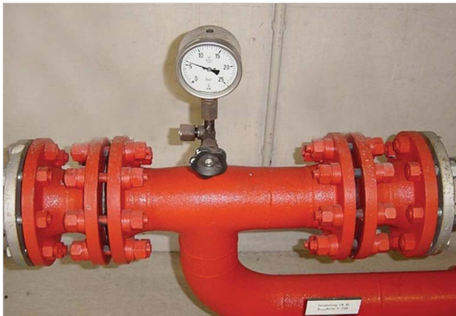
Рис. 2 — Изолирующее фланцевое соединение
